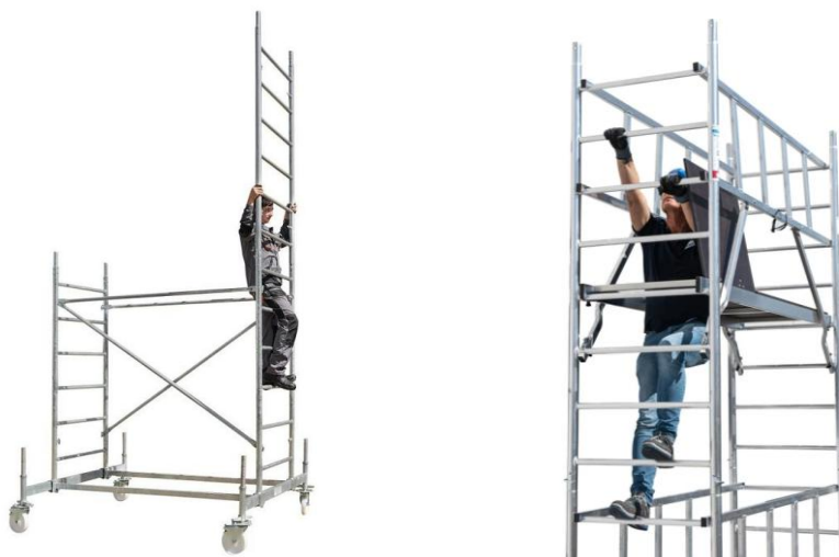
Fig. 48. Instalarea scărilor de acces
